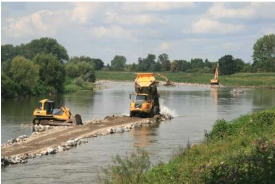
Foto genomen van onder de autobaanbrug te Elsloo.
