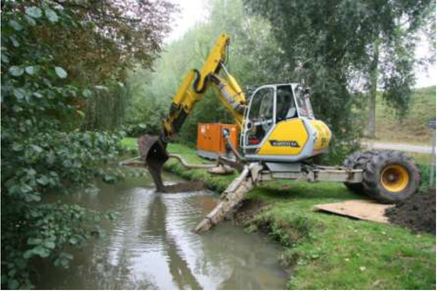
Een damwand wordt aangelegd.
