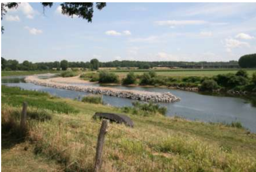
Oever- en bodembescherming Grensmaas te Meers / Kotem zomer 2009
